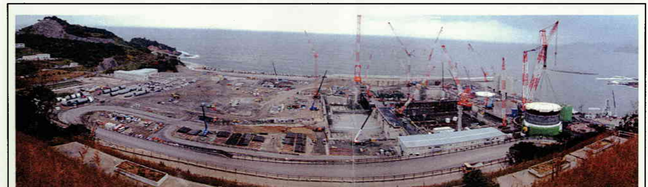
敷地南側からの全景
