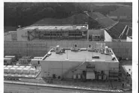
緊急時対策所
