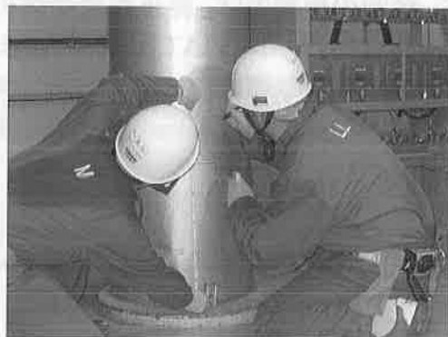
配管へのマーキング作業
