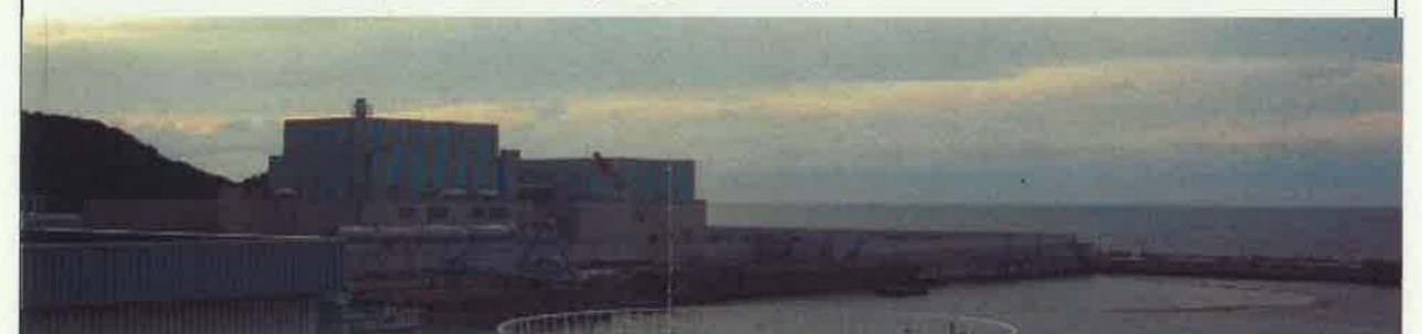
敷地東側からの全景
