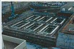
軽油タンク格納槽工事状況 (2020年12月1日現在)
