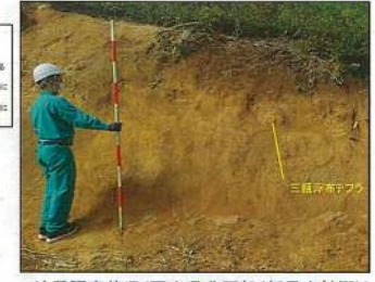
地質調査状況(岡山県北西部(新見市神郷))
