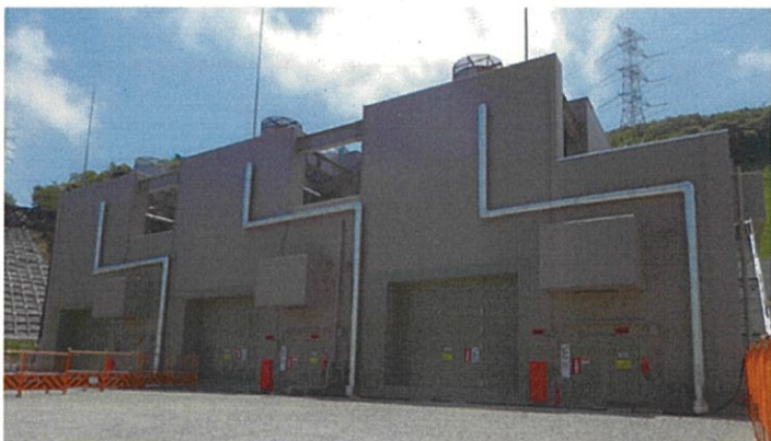
<ガスタービン発電機建物外観>
