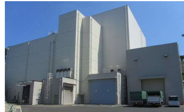
サイトバンカ建物外観
