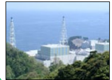
島根原子力発電所
