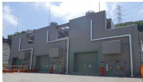
<ガスタービン発電機建物外観>
