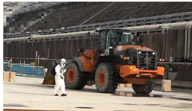
ホイールローダを使用したがれき撤去
