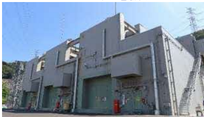
<ガスタービン発電機(2台)>
