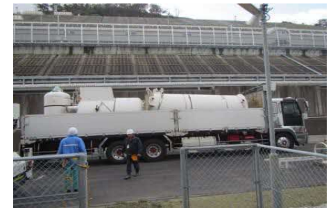
解体物の移送
