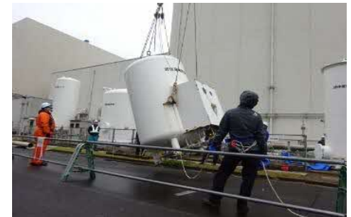
撤去作業の状況
