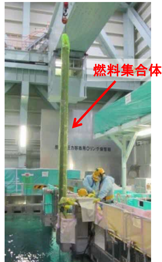
新燃料の引き上げ状況
