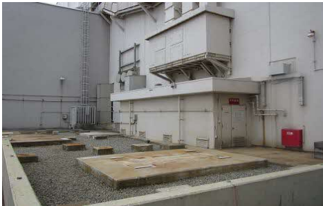
撤去作業後の状況
