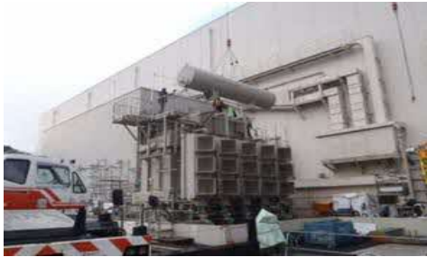
撤去作業の状況
