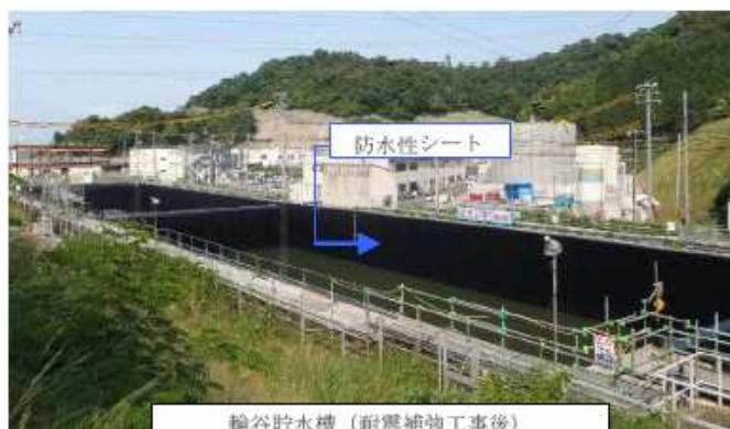
輪谷貯水槽（耐震補強工事後）
