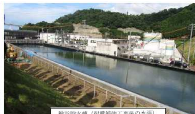
輪谷貯水槽（耐震補強工事後の水張）
