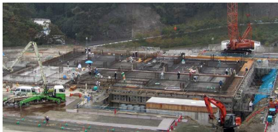
▲基礎工事の様子 (平成25年10月現在)
