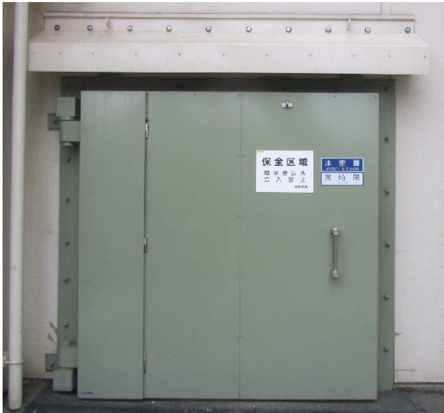
▲ 2号機建物外壁に設置した水密扉
