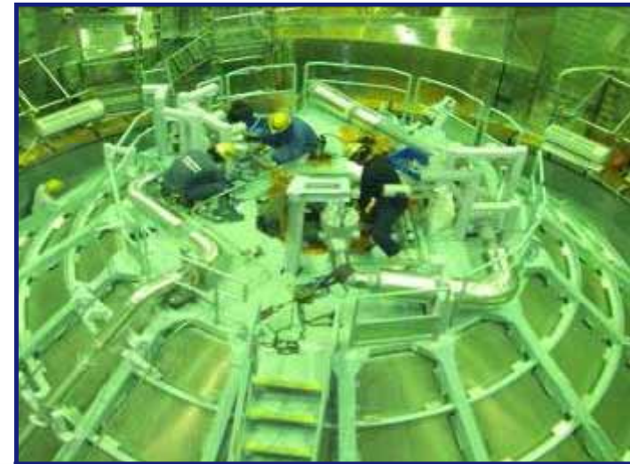
原子炉圧力容器耐圧漏洩試験 (平成22年10月完了)
