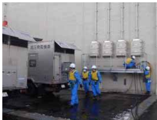
▲ 高圧発電機を用いた電力供給訓練
