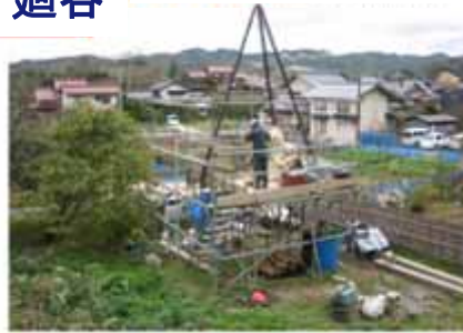
ボーリング調査
