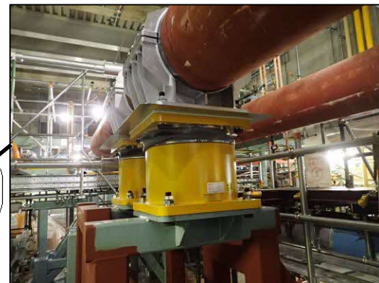
三軸粘性ダンパの設置例
