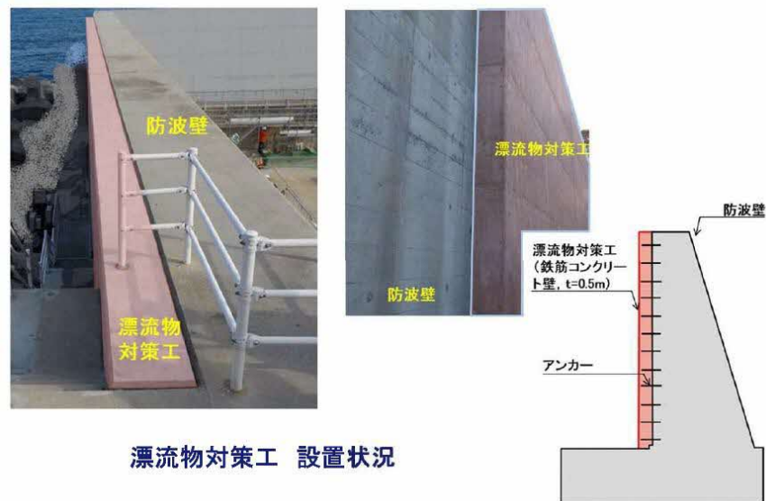
図7 漂流物対策工の設置状況
