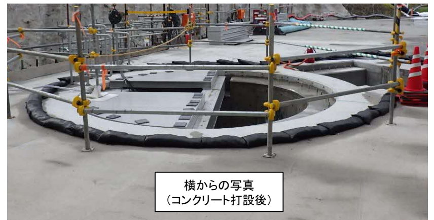
図5 地下水水位低下設備の設置状況
