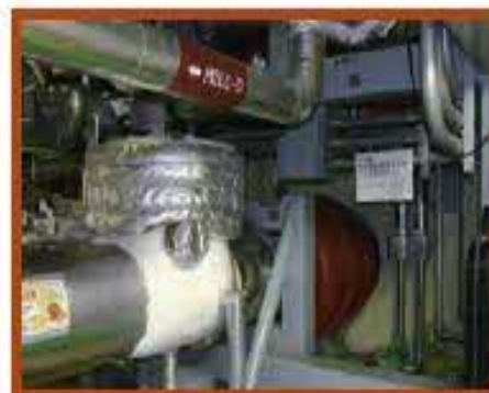
耐震補強工事前
