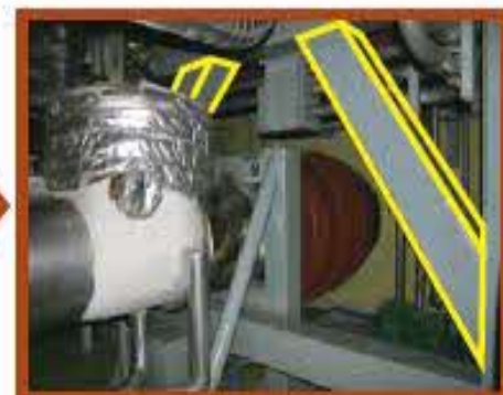
耐震補強工事後
