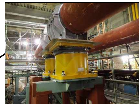
三軸粘性ダンパの設置例
