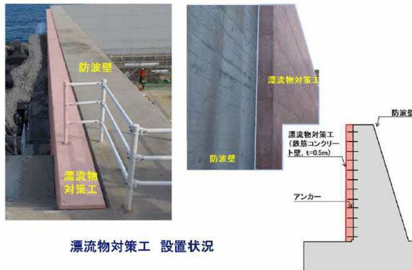
図3 漂流物対策工の設置状況
