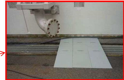
淡水供給側接続口
