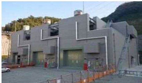
ガスタービン発電機建物 外観
