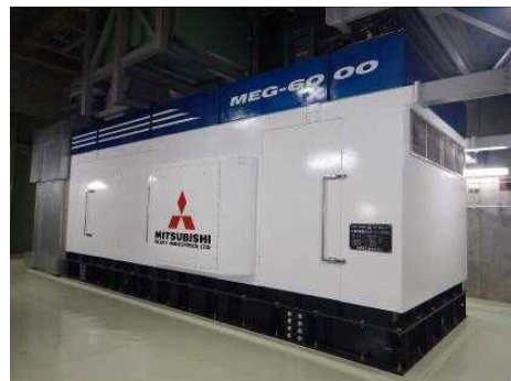
ガスタービン発電機 外観
