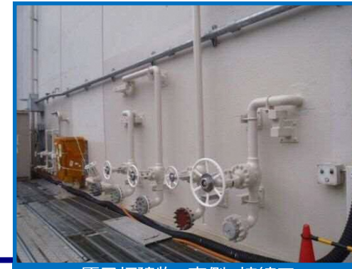
原子炉建物 南側 接続口
