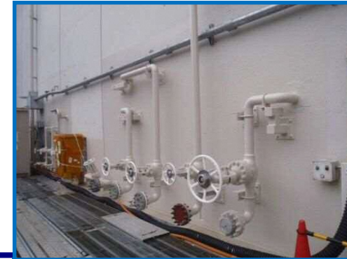
原子炉建物 南側 接続口
