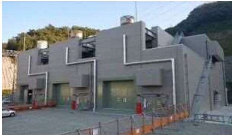
ガスタービン発電機建物 外観
