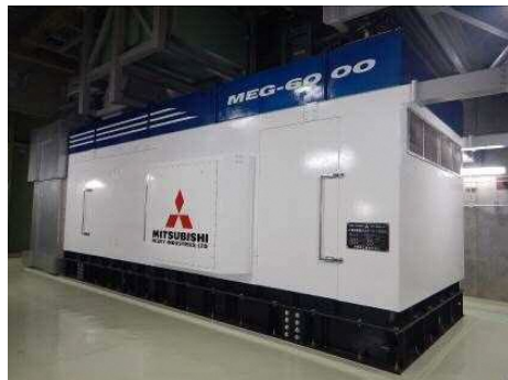
ガスタービン発電機 外観
