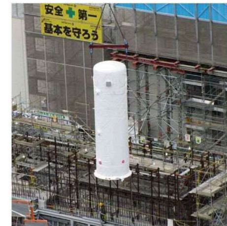
図3 スクラバ容器の吊り込み作業の様子
