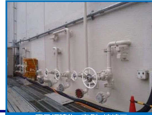
原子炉建物 南側 接続口
