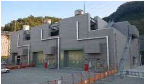
ガスタービン発電機建物 外観
