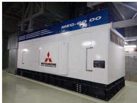
ガスタービン発電機 外観
