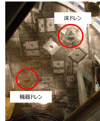
ペDESTアル内床面を上から見た写真 (コリウムシールドの外観)
