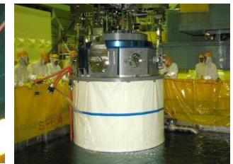
(写真3) 燃料プールから輸送容器吊り上げ
