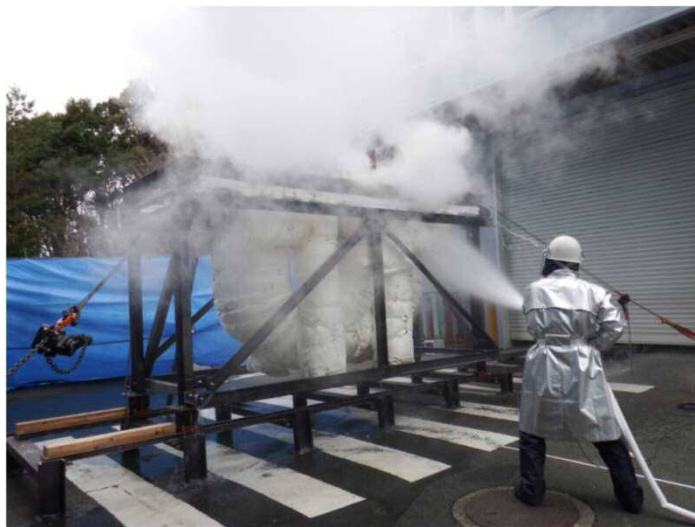
放水試験(3時間耐火試験後)
