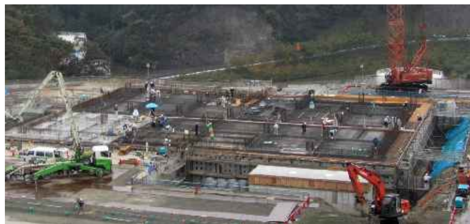
基礎工事の様子 (平成25年10月現在)
