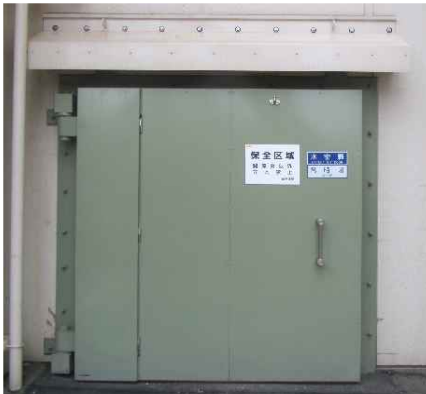
2号機建物外壁に設置した水密扉
