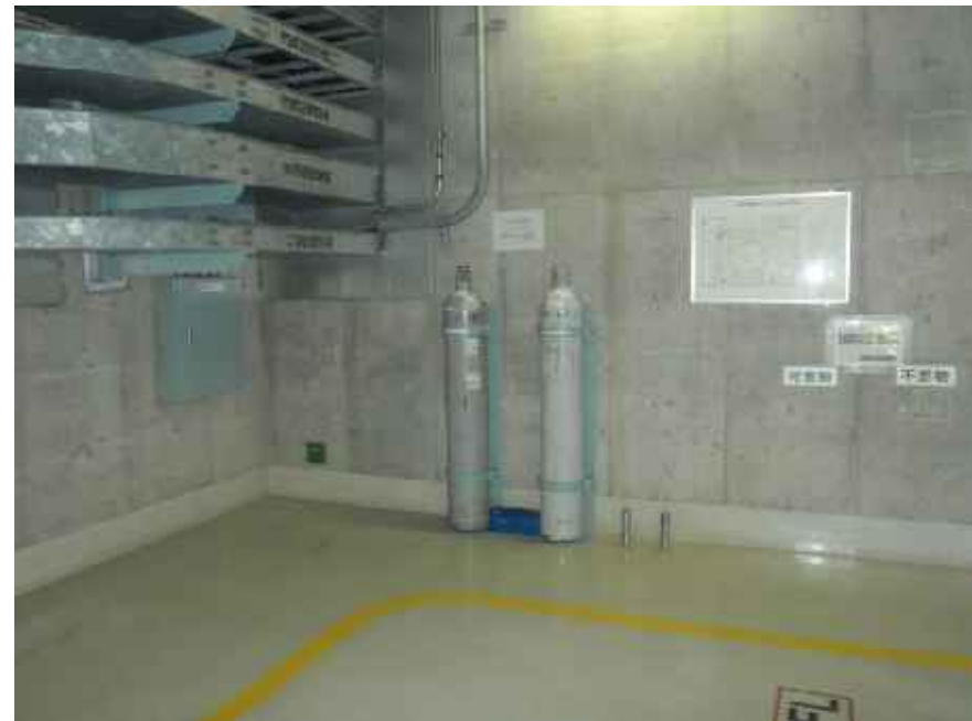
窒素ガスポンベ
