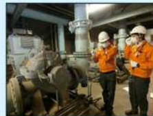
火力発電所での現地研修
