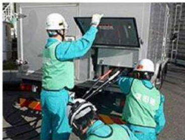
高圧発電機車による電源供給訓練
