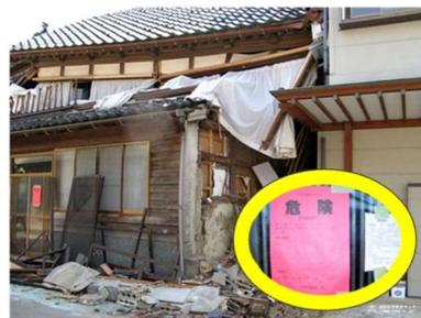
倒壊の危険がある住宅と応急危険度判定結果
