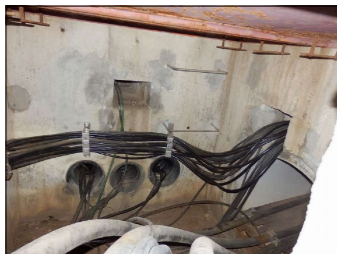
⑤屋外変圧器(7500KVA)へ
