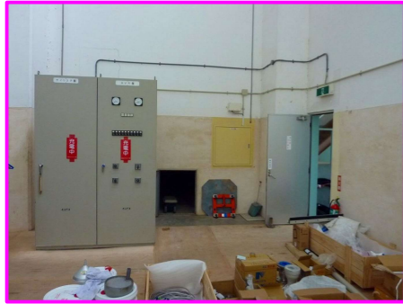
⑥発電機室全景
