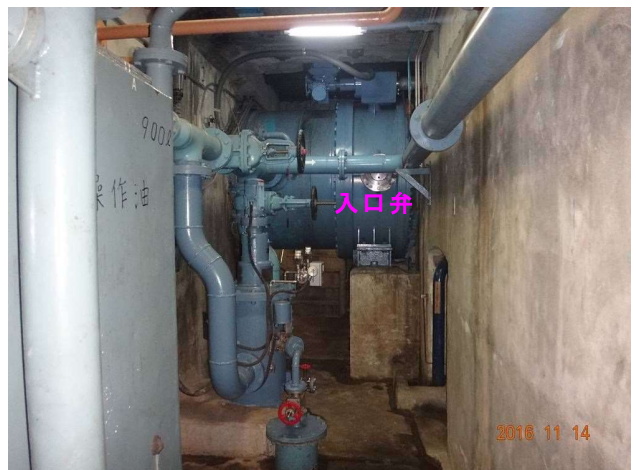
写真-3.2.9.6 地下廊（地下2階）
