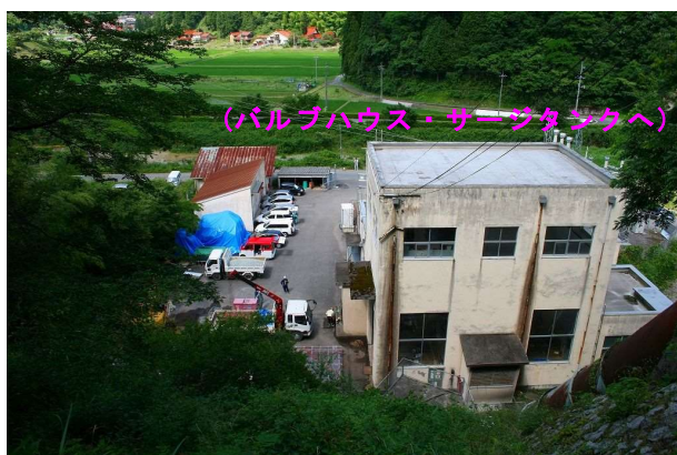
写真-3.1.7 発電所付近鉄管沿い
