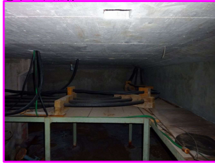
⑦ラック配線
