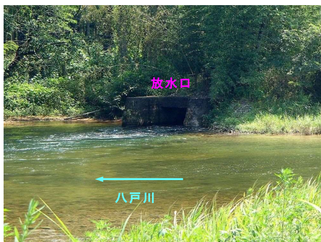
写真-3.2.11.3 放水口 (対岸より)
