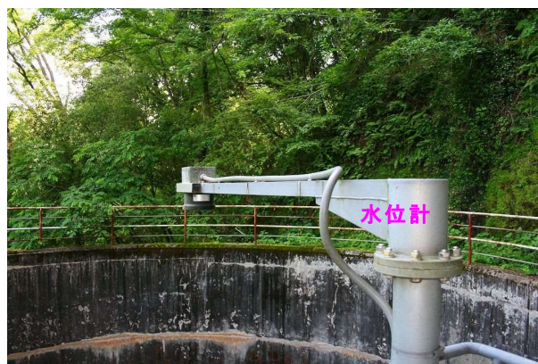
写真-3.1.10 サージタンク
