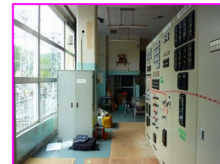
①配電盤室全景
