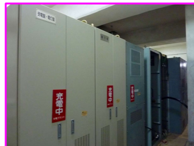
⑥水車室全景
