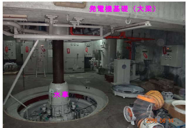
写真-3.2.9.4 水車室（地下1階）
