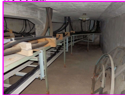
⑪ラック配線
