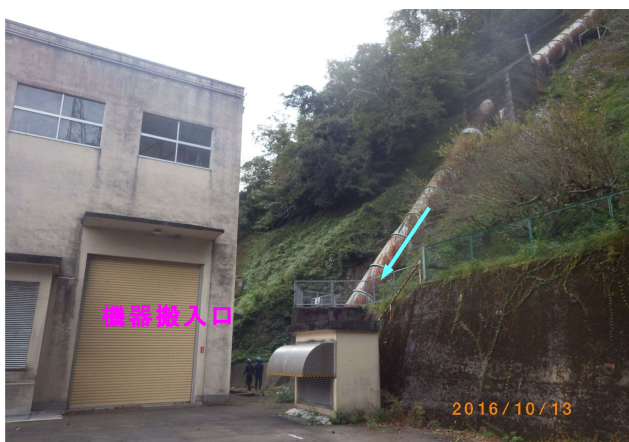
写真-3.2.10.5 機器搬入口
