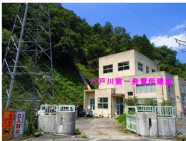
写真-3.1.1 発電所建屋
