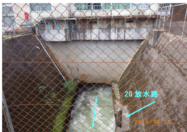
写真-3.2.11.1 放水庭 (上流側)
