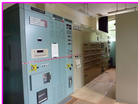
②配電盤室全景
