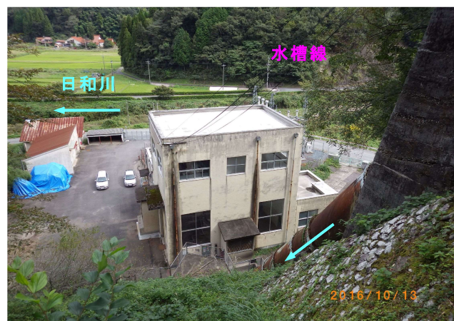
写真-3.2.10.4 発電所建屋（山側より）
