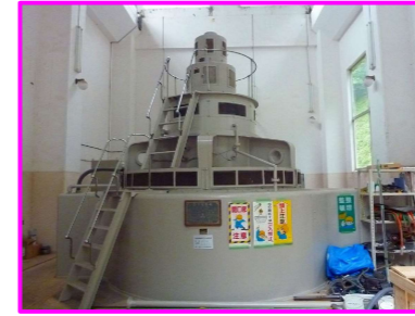
④発電機室全景
