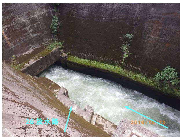
写真-3.2.11.2 放水庭 (下流側)
