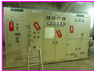
④水車室全景
