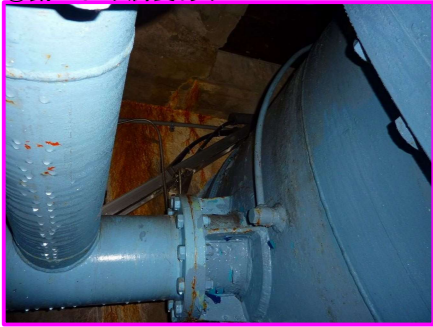
②錆により腐食あり
