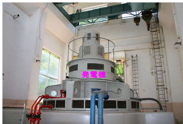
写真-3.1.4 1号機発電機
