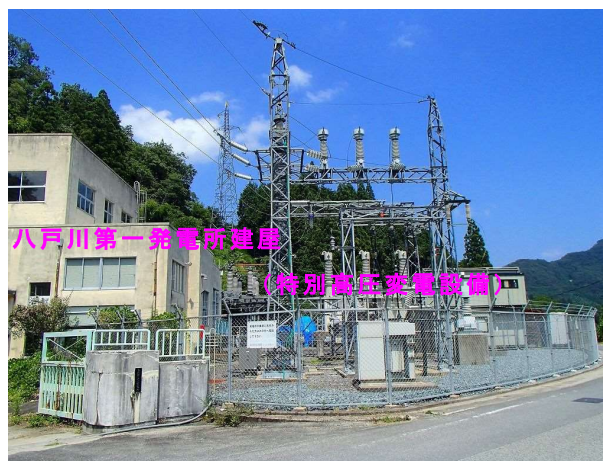
写真-3.1.2 特別高圧変電設備
