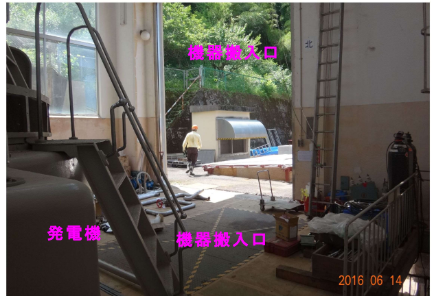
写真-3.2.9.2 機器搬入口
