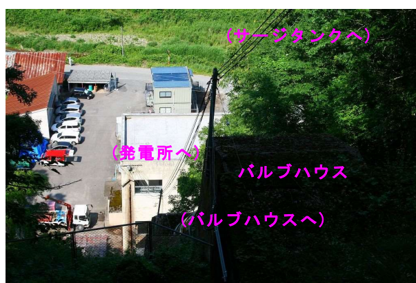
写真-3.1.8 バルブハウス付近
