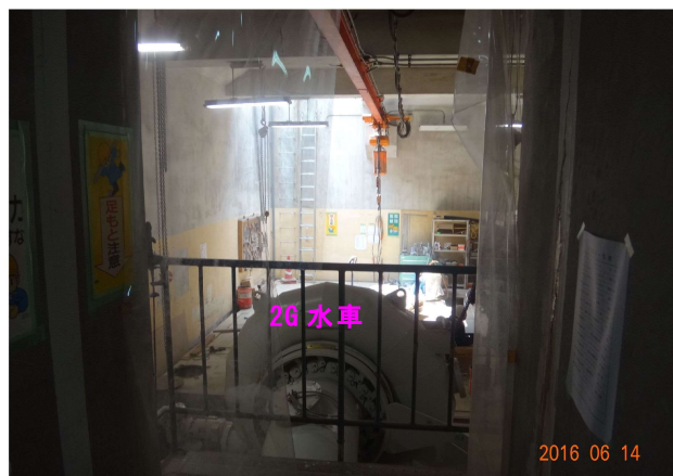
写真-3.2.10.6 2号機発電所
