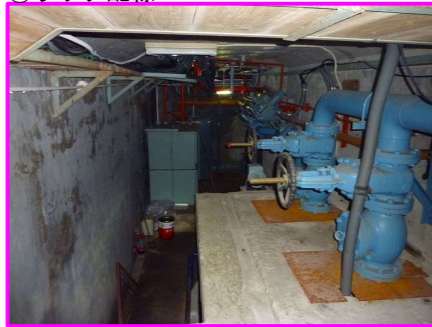
⑨ラック配線
