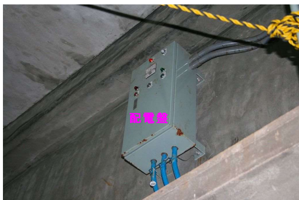
写真-3.1.9 バルブハウス内
