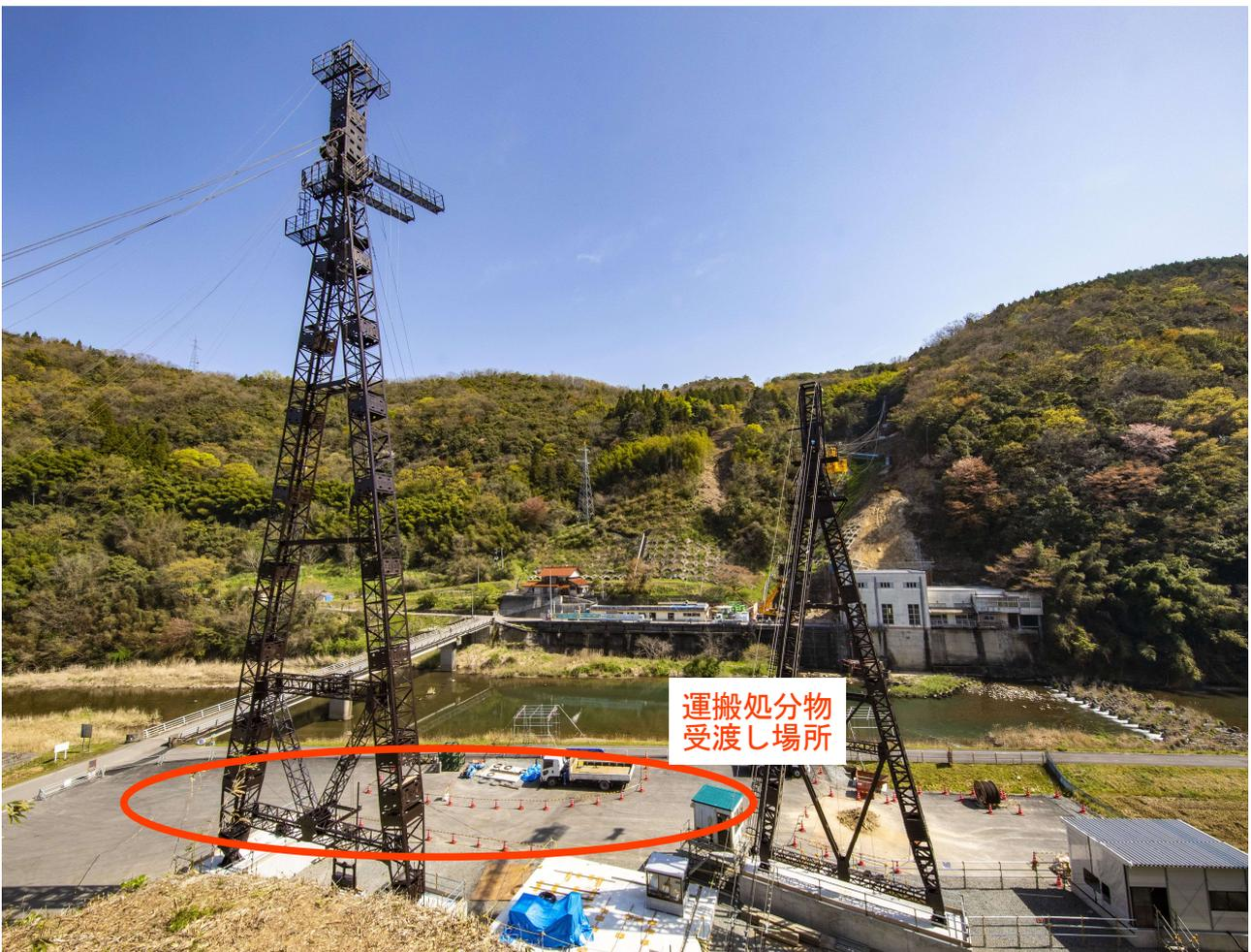
運搬処分物は、索道を用いて対岸斜面上から運び出し、索道鉄塔のあるヤードにて受渡す。
