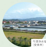
令津浄水場 (安来市)
