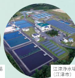
江津浄水場 (江津市)
