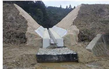
〈廃止工事（堤体の開削）（松江市）〉
