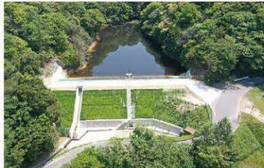
〈堤体改修後のため池（出雲市）〉
