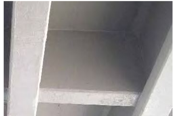
補修後の状況
