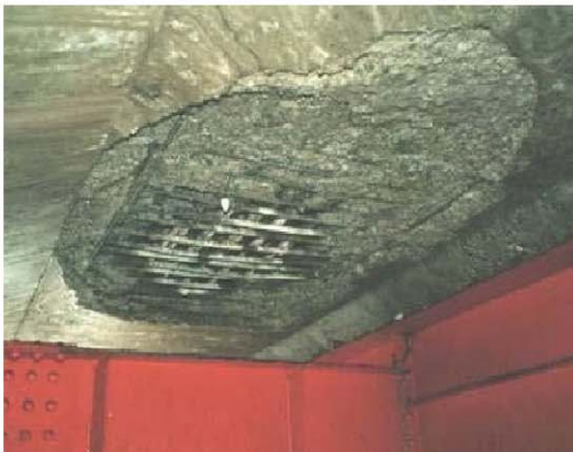
床版の打ち替え(交換)例
