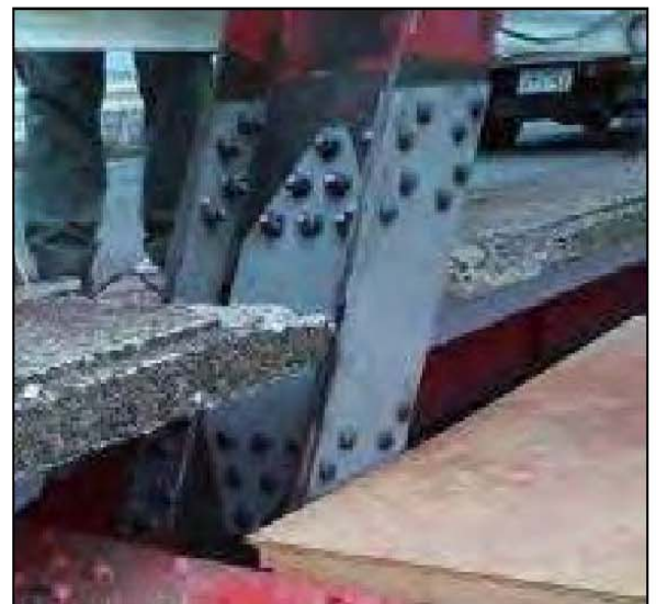
補修後の状況
