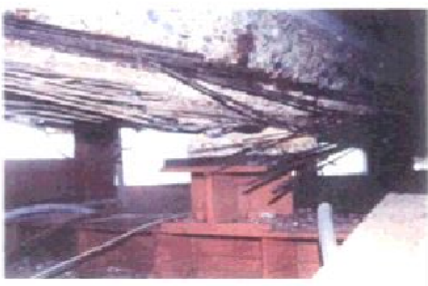
塩害による主桁の損壊(1966年建設)
