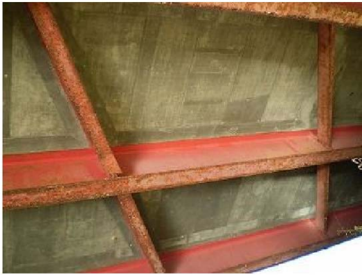
鋼桁の腐食
