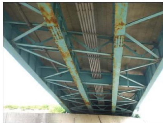
鋼桁腐食
