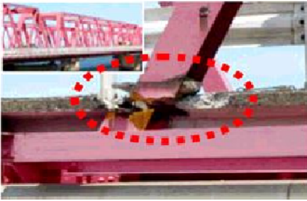
塩害による主桁の損壊(1966年建設)
