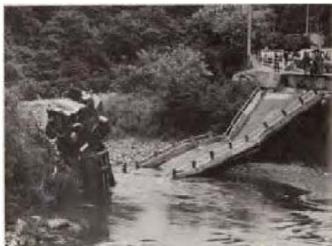
落橋事例3 長野県新菅橋(PC橋)の落橋(1989年)
