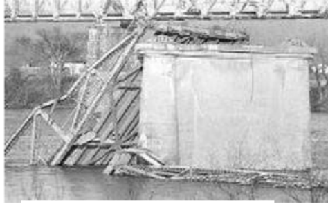
落橋事例1 アメリカシルバー橋(吊橋)の落橋(1967年)
