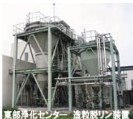
【写真左】造粒脱りん装置は、処理水中のリンをリン酸マグネシウムアンモニウム（MAP）の結晶として回収するもので、取り出したリンは、肥料の原料として再利用しています。
