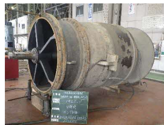
整備前の排水機
