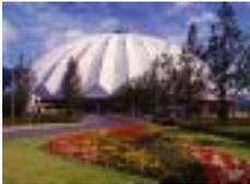
出雲市にある出雲ドームは日本最大の木造建築として平成4年4月にオープン。高さ48.9mのドームのアーチは、米国から輸入した約2000トンの集成材で構成されている。
