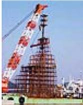
浜田市沖の日本海に新たな漁場開発を目指して、高さ40m(12~13階相当)、重さ109tの高層魚礁(マンモスリーフ)が2基設置された。
