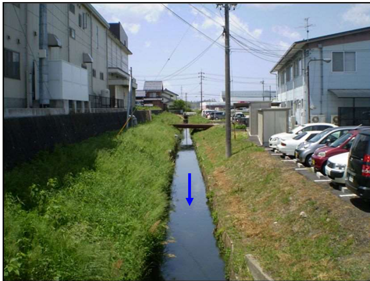
改修前(斐川支所付近から上流)
