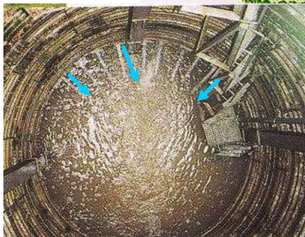
集水井内の様子
