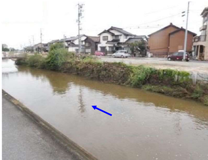
改修前(木戸橋から下流)
