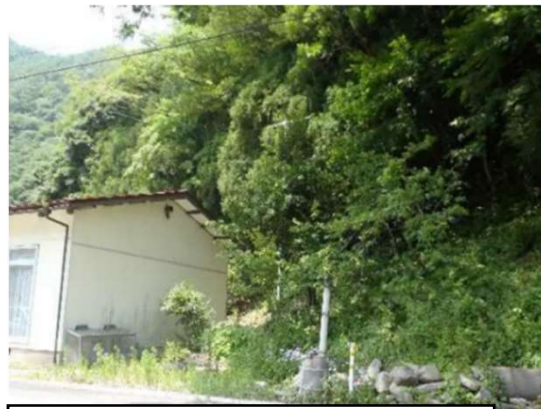
集会所裏斜面状況
