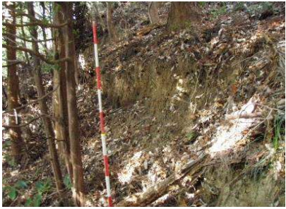
①斜面の崩壊状況
