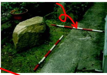
③H15落石発生(直径1m)
