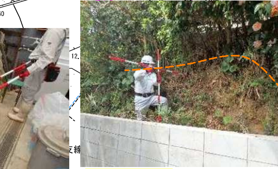
Ph-22 崩壊跡 市道下方斜面の崩壊跡である。
