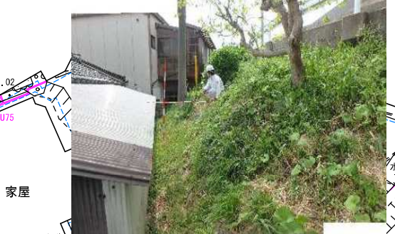
Ph-20 斜面状況 土塊の押し出し兆候のある斜面である。
