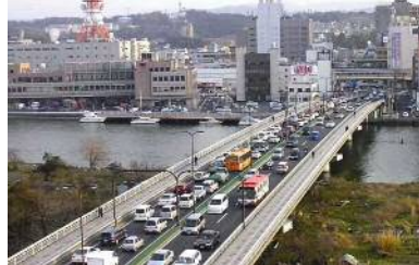
松江市街地の4橋の平日24時間交通量は約11万台。中海大橋においても朝夕に渋滞が発生。
