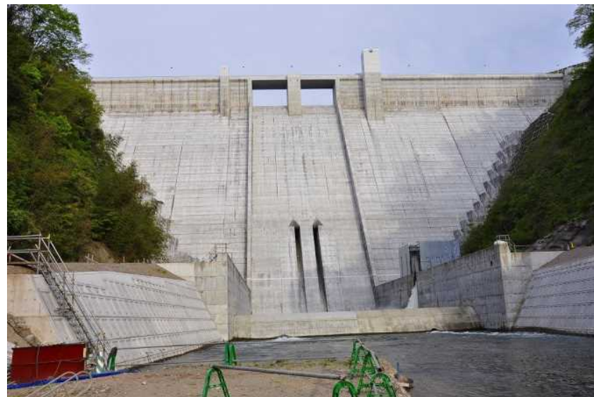
現況写真 ダム下流面 (H28.5)
