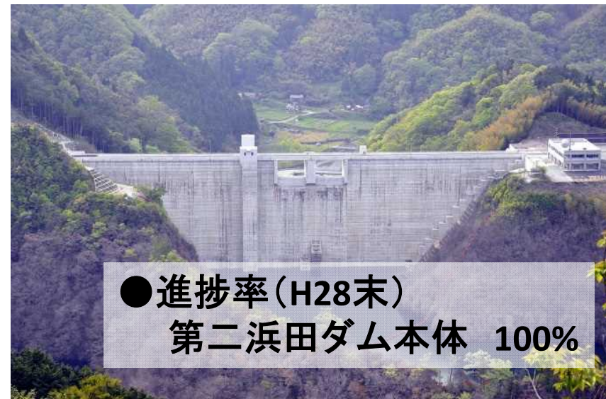
現況写真 ダム上流面 (H28.5)
