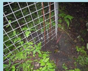
下部から侵入された防護柵の補修例
