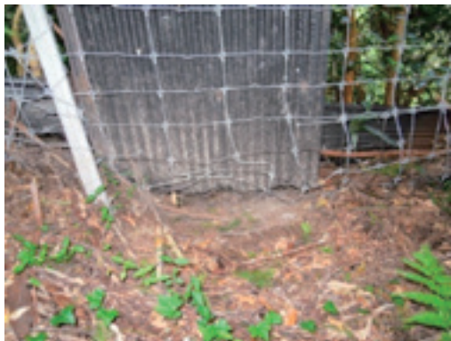
写真1 イノシシの侵入によってできた隙間をトタンで修繕した状況 (A 地区)
