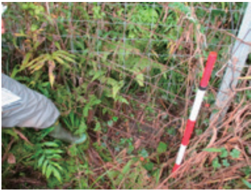
写真9 扉の下部の隙間の修繕 (B地区)
