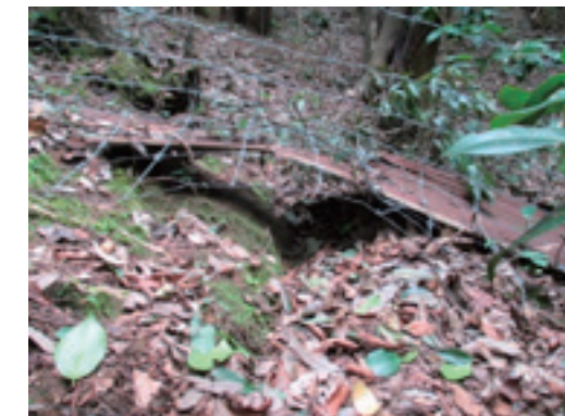
写真6 下部の隙間 (A 地区)
