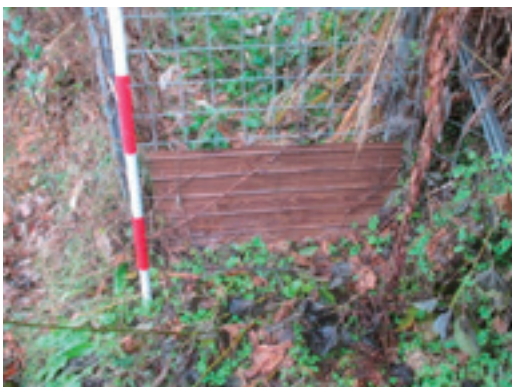
写真13 扉の下部の隙間の修繕 (C地区)
