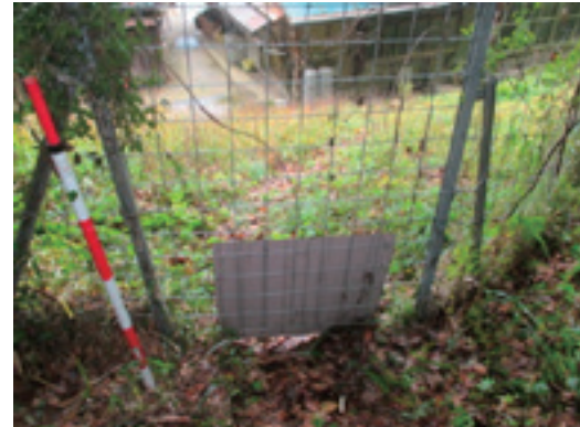
写真14 扉の下部の隙間の修繕 (C地区)
