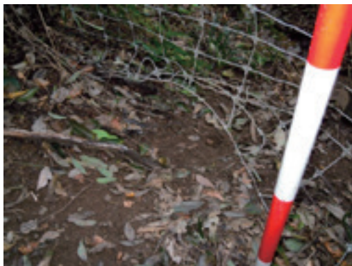
写真5 下部の突破した隙間 (A 地区)
