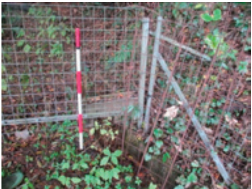
写真11 水路の隙間の修繕 (B地区)
