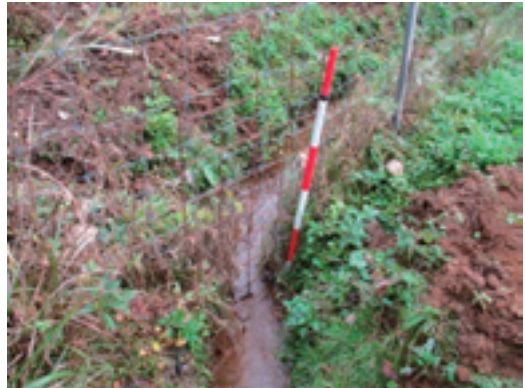
写真10 水路の隙間の修繕 (B地区)
