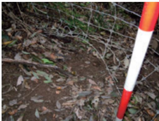
写真5 下部の突破した隙間 (A 地区)
