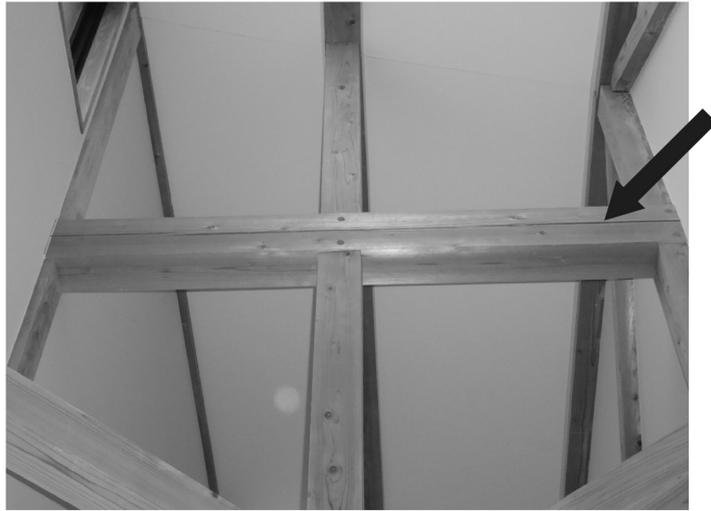
写真1 建築物のスギ構造材に生じた干割れ（矢印）
