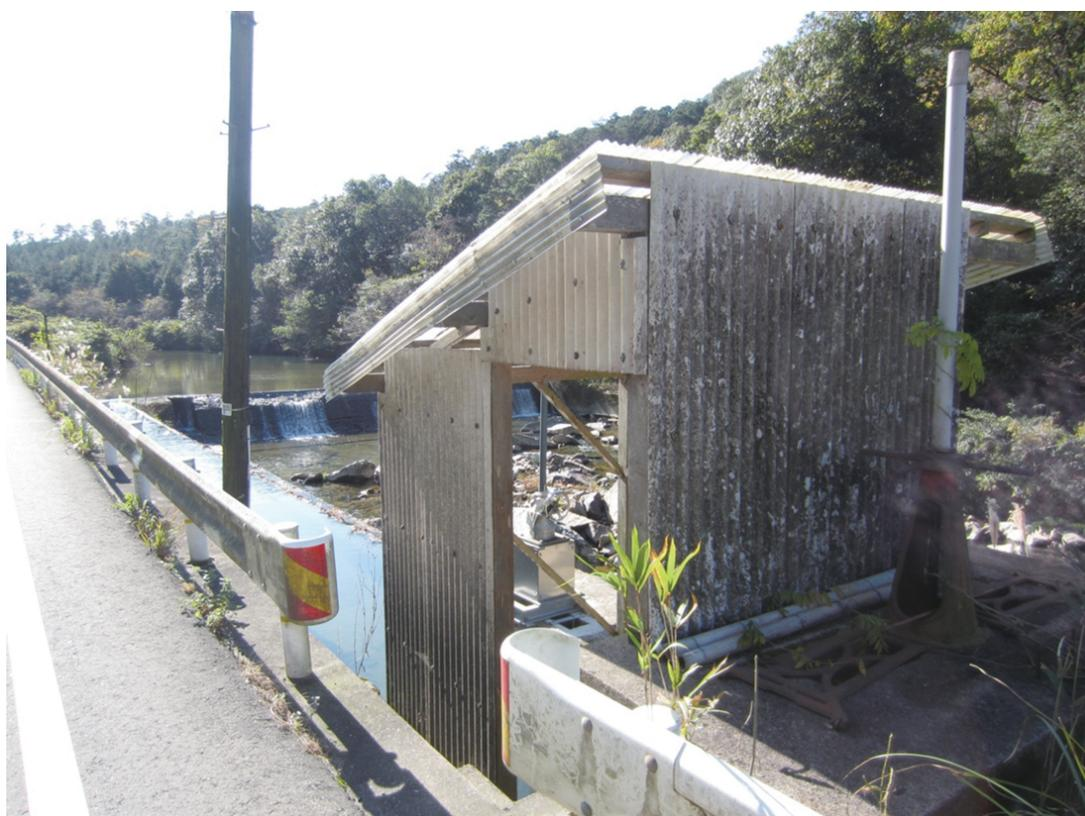
写真3 「雨でも雪でも掃除しやすいように」という工夫（志和堀発電所・東広島市の取水口）
