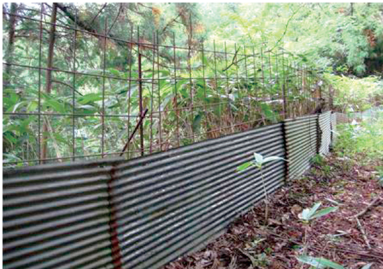
写真2 八代東部集落に設置されたワイヤーメッシュ柵
