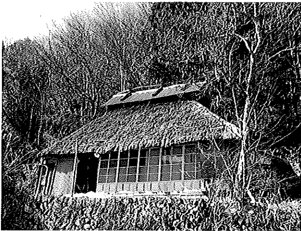
約30年間放置されている空き家
