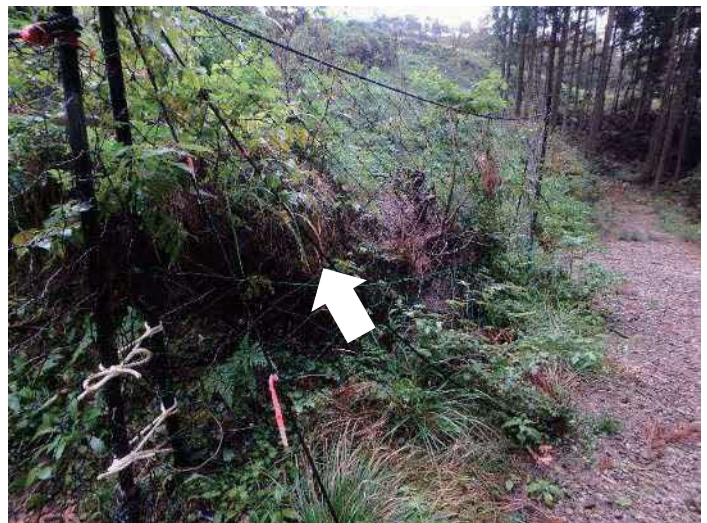
写真12 ネット柵が斜面と接しているために侵入した箇所
